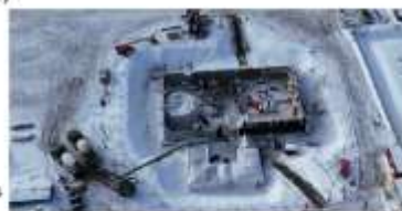
Construction de l'usine de remblai en pâte cimentée - mars 2026
