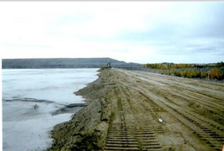
PHOTO 2 – Élargissement de la surface de la digue, mise en place de la 1<sup>ère</sup> couche de matériau de rehaussement.
