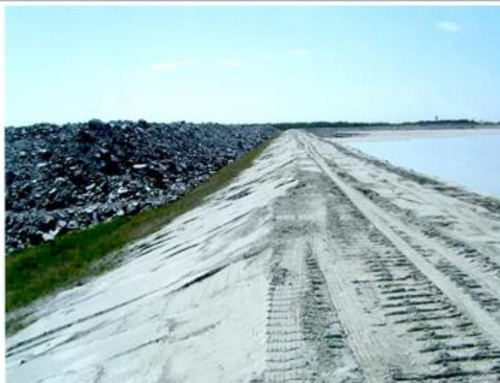
PHOTO 4 – Rehaussement et égalisation de pente de la digue périphérique sud
