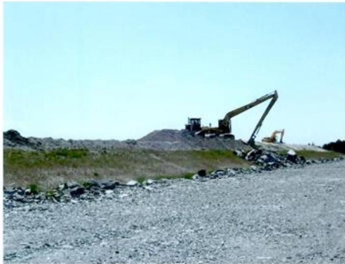
PHOTO 3 – Rehaussement et égalisation de pente pour la digue périphérique Nord
